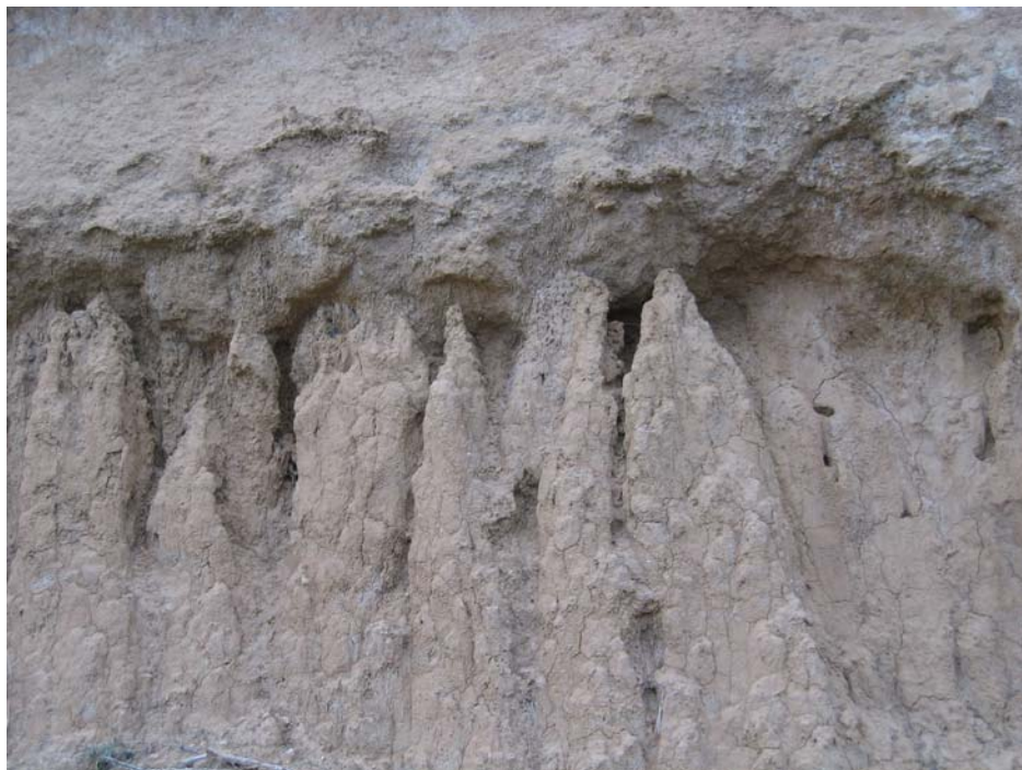
Foto 7.8. Procesos de piping en los niveles arcilloso-limosos de la Fm Uncastillo.
