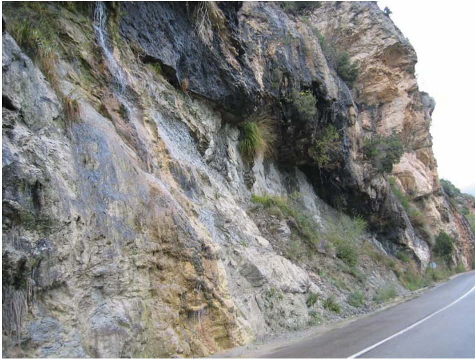
Foto 7.2. Surgencia de agua a favor del cabalgamiento de la carretera al situar las calizas eocenas sobre las margas de Arguis.
